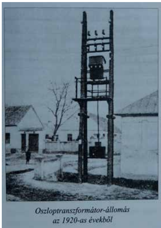
Hódmezővásárhelyi utca elektromos vezetékkel és transzformátorállomással a villamosítás kezdeti időszakában
