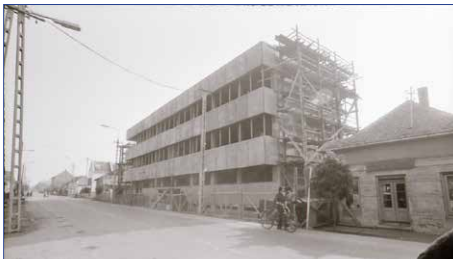
Paksi posta építése, 1978
